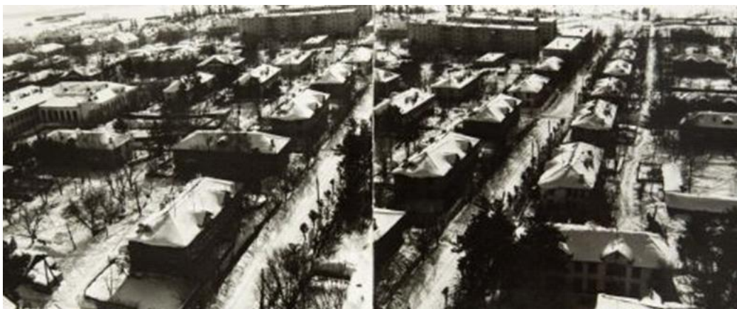
Фото 04. Слева видны две пятиэтажки - ул. Коммунистическая, 53 и 55
